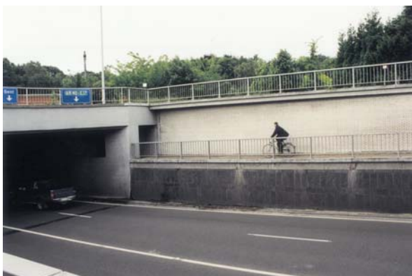
Foto 4.66 Tunnel met een verschillende helling voor auto- en fietsverkeer
